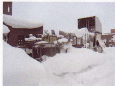
写真2 クリーンルーム用チラー等設備 (H18年1月)
