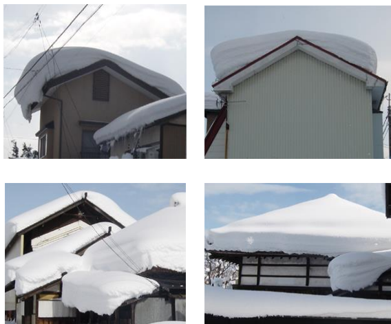
図 1. 屋根の構造・位置・風向き等による積雪深の差異例
