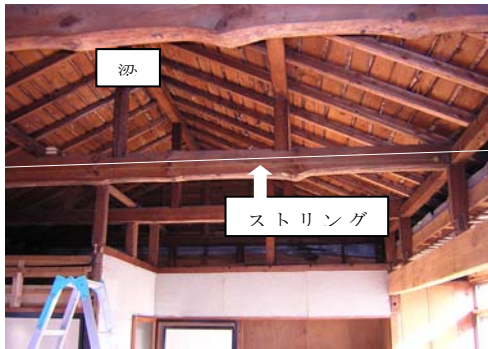
図6 屋根雪監視に関する専用実験棟 天井を取り去り梁の撓みを計測
